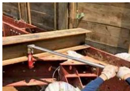
★施工時の締付トルク【300N・m】の徹底★
