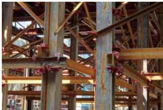
万力式金具の両端に、先端を特殊加工した高力ボルトを取り付け接合する鋼材を挟んで締め付け、高力ボルト先端を鋼材に食い込ませ、このクランプ力によって接合します。
