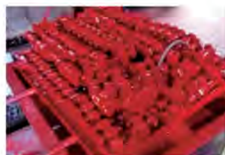
④防錆処理
