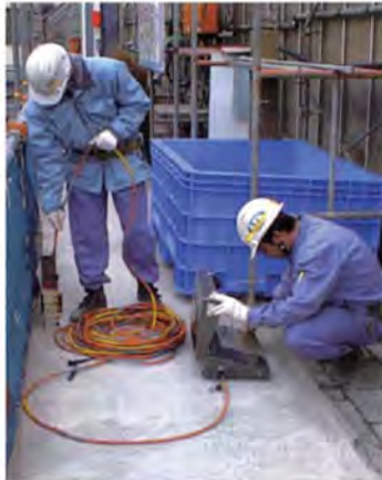
山留め壁の変形計測状況
