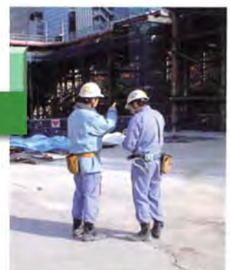
現場打ち合わせ状況
