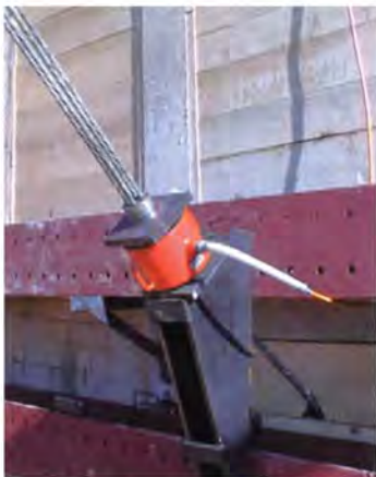
バックアンカー軸力計設置状況
