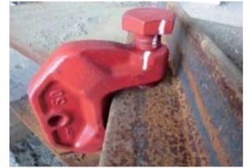
マーキングのズレを発見した場合は専用トルクレンチで締め直して下さい。
